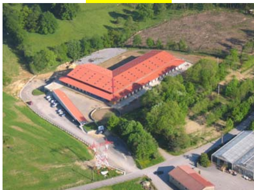
INSTALACIONES ZELAI ALAI
