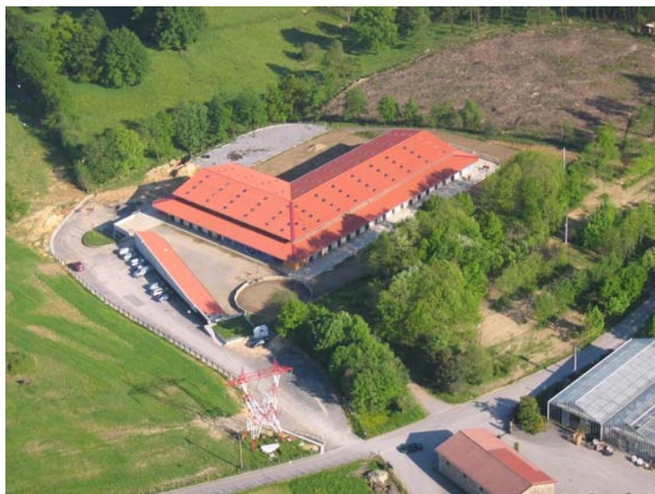
INSTALACIONES ZELAI ALAI
